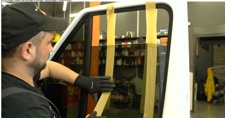
12 Kinnitage klaas aknaraami külge. Kasutage maalriteipi.
